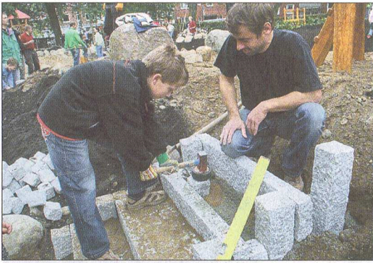
Schritt für Schritt geht's voran: Bjarne Westphal (l.) legt zusammen mit Neithardt Kempcke aus Granitstein eine kleine Treppe an.
